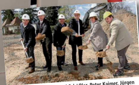
Da fliegt der Sand: Michael Schüßler, Peter Kaimer, Jürgen Hoffmann, Sven Korsch, Claudia Jäger und Dr. Karsten Falk (von links) beim ersten Spatenstich für das Johanniter-Quartier an der Friedensstraße. Hinter ihnen steht der Bagger schon bereit. © Wolf Quelle: Offenbach Post 16.04.2016
